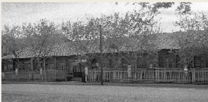
Здание на месте бывшей церковно - приходской школы при церкви Святой Троицы Фото 1970 г.
